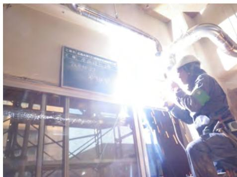
図－３ 作業による光で作業箇所が見えない例
