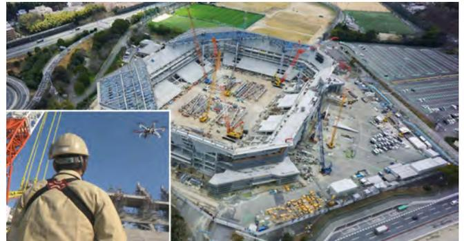
図－7 マルチコプタによる空撮写真の実用化事例
