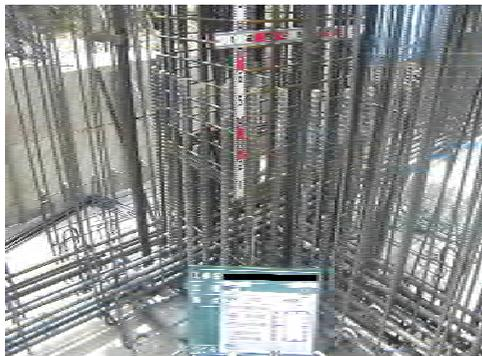
図－１ スケールを設置し配筋を確認する例
